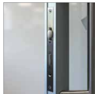
Serrure à rouleau Roller lock
